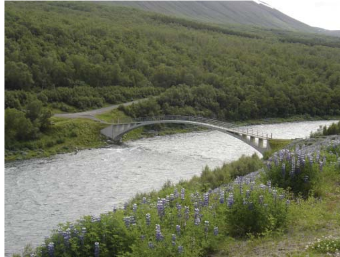
Brúin yfir Fnjóská í nágrenni Vaðlaheiðar byggð árið 1908. Fyrsta steinbogabrúin hér á landi og þá talin ein sú lengsta Evrópu.
