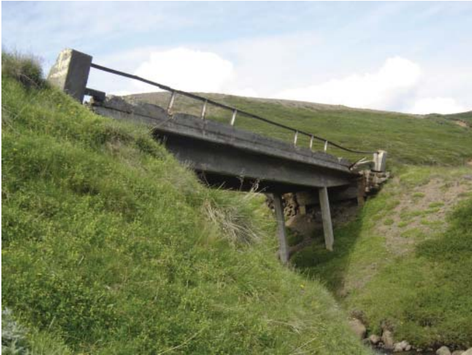
Brú á Vaðlaheiðarvegi.
